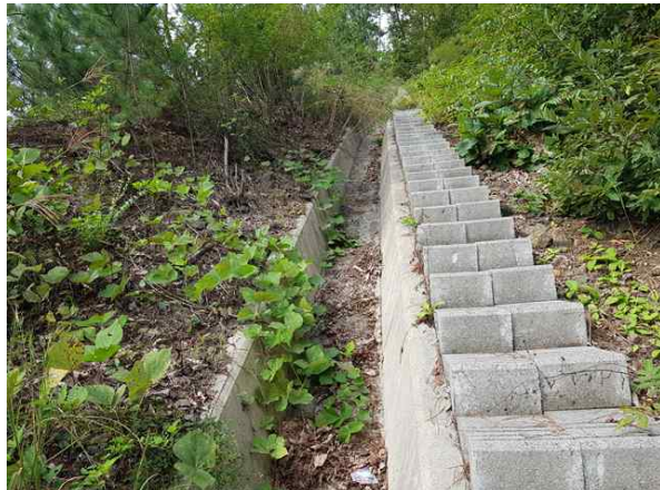
점검계단, 산마루측구 전경
